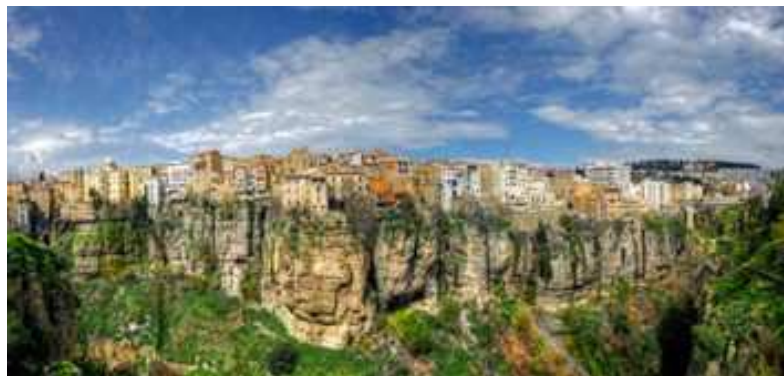
Fig. 6. Paysage de la ville de Constantine construite sur le Rocher (un bloc de calcaire)
